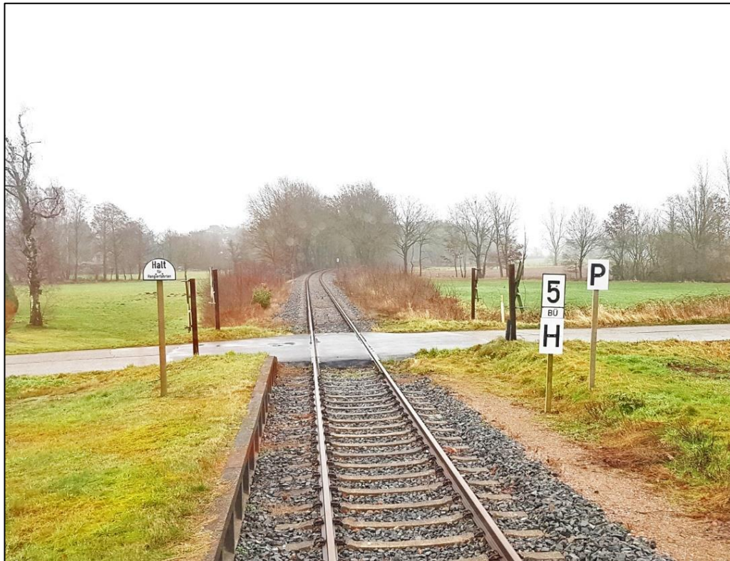
Heidenau in Richtung Tostedt [eigene Aufnahme]
